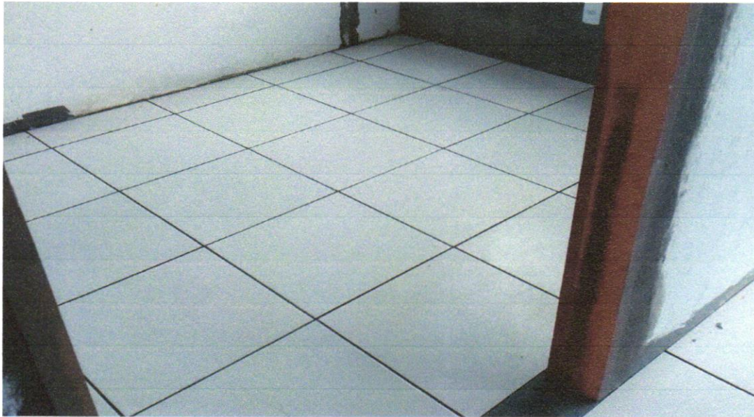
FOTO 27 - REVESTIMENTO CERÂMICO PARA PISO COM PLACAS TIPO ESMALTADA EXTRA DE DIMENSÕES 45X45 CM APLICADA EM AMBIENTES DE ÁREA ENTRE 5 M2 E 10 M2. AF_06/2014
