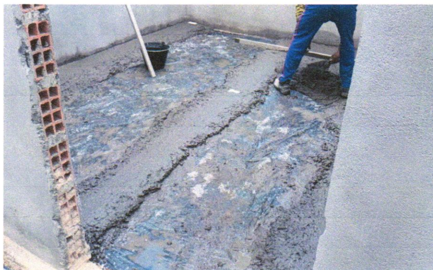
FOTO 20 - (COMPOSIÇÃO REPRESENTATIVA) DO SERVIÇO DE CONTRAPISO EM ARGAMASSA TRAÇO 1:4 (CIMENTO AREIA), EM BETONEIRA 400 L, ESPESSURA 3CM ÁREAS SECAS E 3 CM
