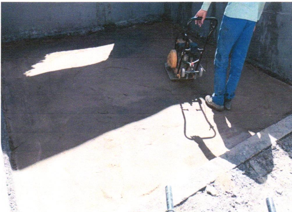
FOTO 26 - Regularização mecanizada de áreas
