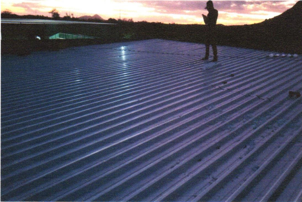
FOTO 05 – TELHAMENTO COM TELHA METÁLICA TERMOACÚSTICA E = 30 MM, COM ATÉ 2 ÁGUAS, INCLUSO IÇAMENTO. AF_07/2019
