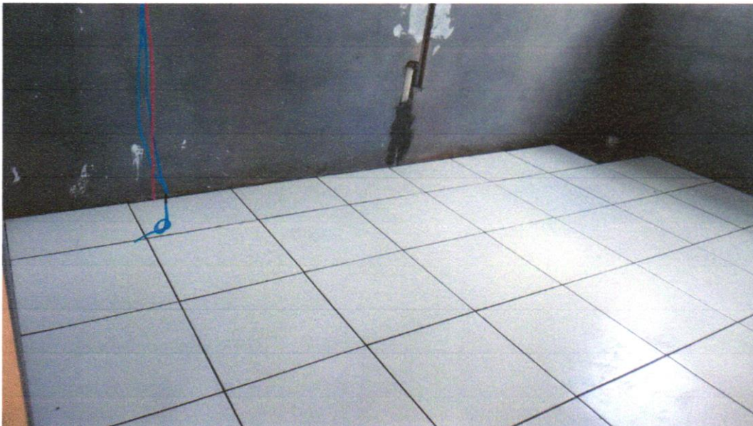
FOTO 30 - REVESTIMENTO CERÂMICO PARA PISO COM PLACAS TIPO ESMALTADA EXTRA DE DIMENSÕES 45X45 CM APLICADA EM AMBIENTES DE ÁREA ENTRE 5 M2 E 10 M2. AF_06/2014
