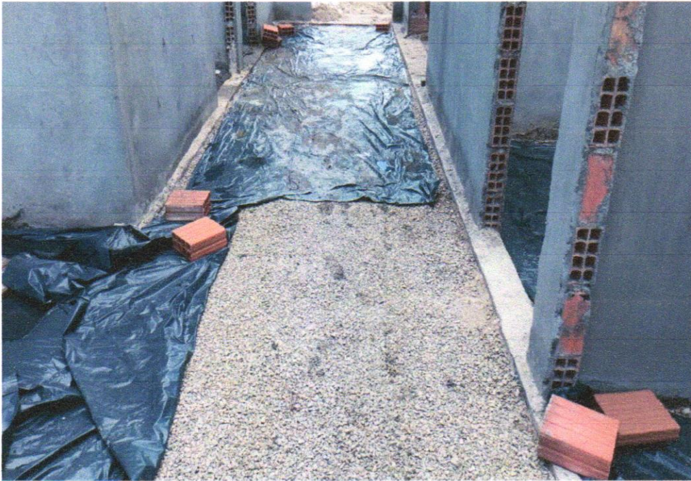
Foto 17 - Lastro de brita graduada apilada e=10cm
