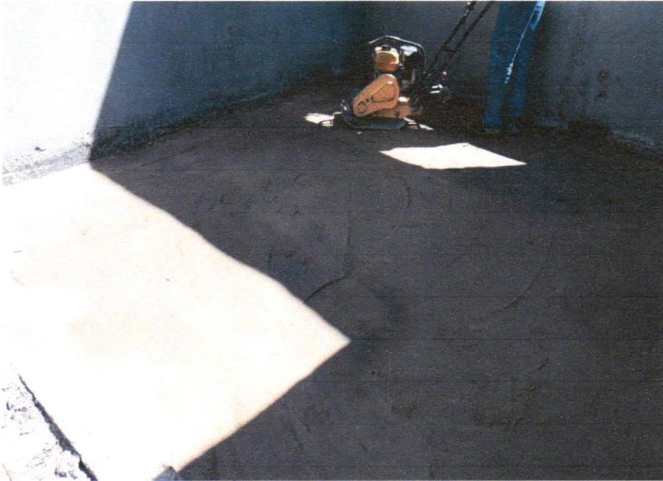
FOTO 25 - Regularização mecanizada de áreas
