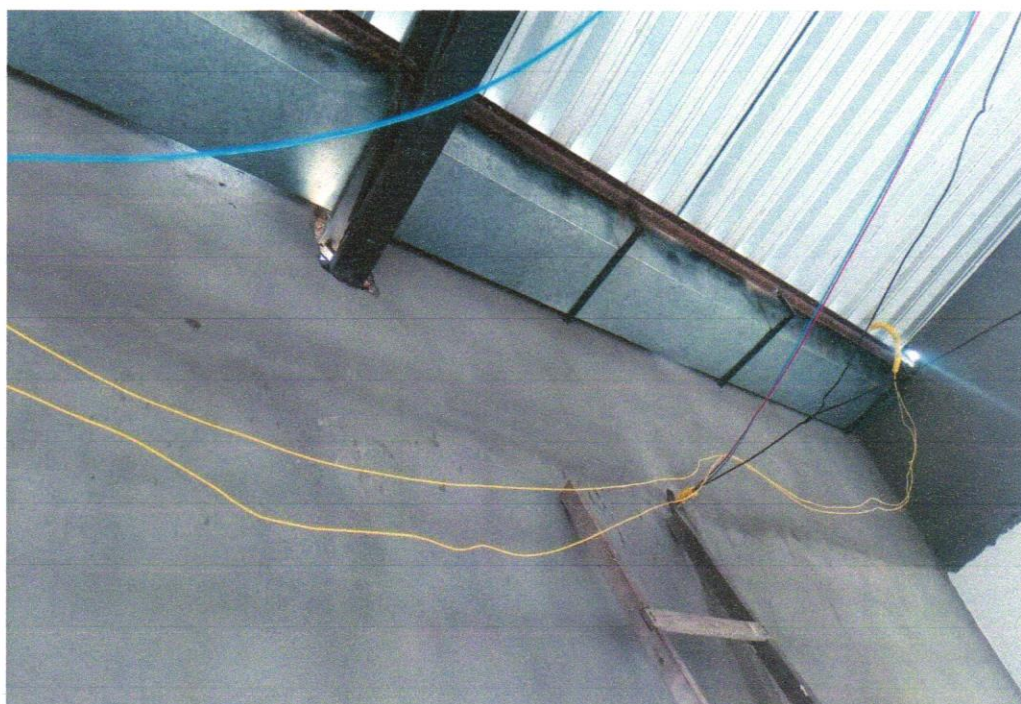
FOTO 08 – CALHA EM CHAPA DE AÇO GALVANIZADO NÚMERO 24, DESENVOLVIMENTO DE 100 CM, INCLUSO TRANSPORTE VERTICAL. AF_07/2019
