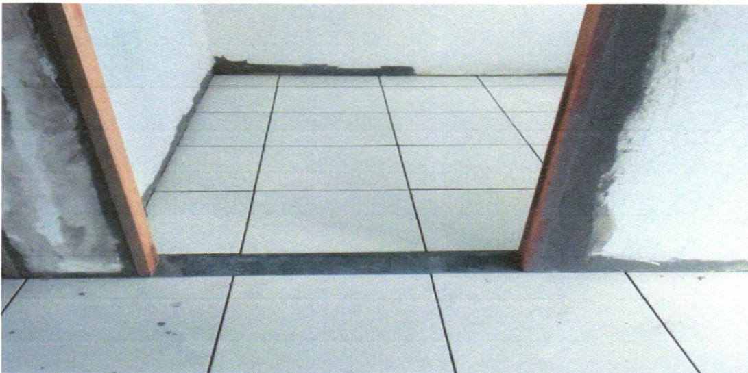
FOTO 28 - REVESTIMENTO CERÂMICO PARA PISO COM PLACAS TIPO ESMALTADA EXTRA DE DIMENSÕES 45X45 CM APLICADA EM AMBIENTES DE ÁREA ENTRE 5 M2 E 10 M2. AF_06/2014
