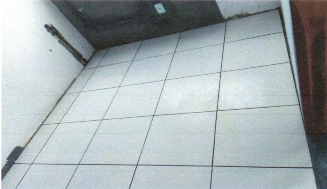
FOTO 29 - REVESTIMENTO CERÂMICO PARA PISO COM PLACAS TIPO ESMALTADA EXTRA DE DIMENSÕES 45X45 CM APLICADA EM AMBIENTES DE ÁREA ENTRE 5 M2 E 10 M2. AF_06/2014
